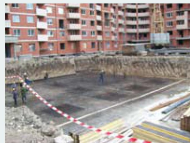
Строительство подземного паркинга на 86 маш/мест по адресу : г. Краснодар, ул. Тюляева, д.4/1. В качестве гидроизоляции были использованы материалы «Пенетрон Адмикс» и «Пенебар».
